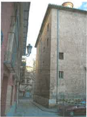
Fachada recayente a la calle Luchente
