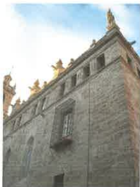
Fachada recayente a la calle Vieja de la Paja
