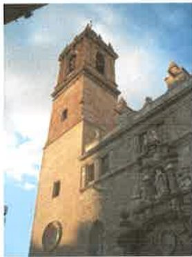
Torre Campanario desde la calle Vieja de la Paja
