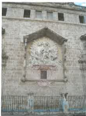
Detalle fachada desde la plaza del Mercado
