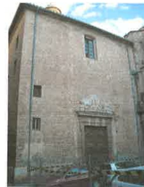
Fachada Capilla de la Comunión desde la Plaza de la Comunión de San Juan
