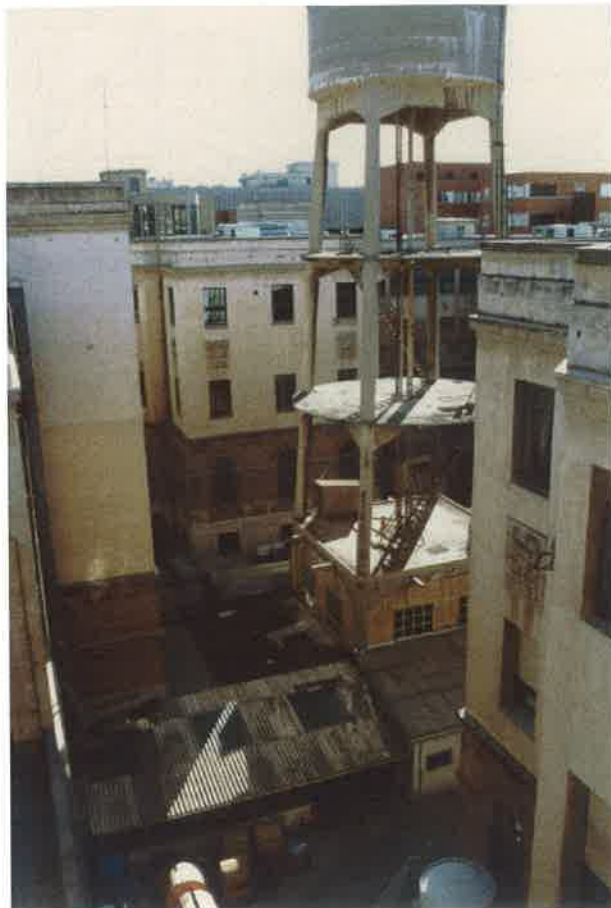
ESTADO ACTUAL DEL PATIO INTERIOR
