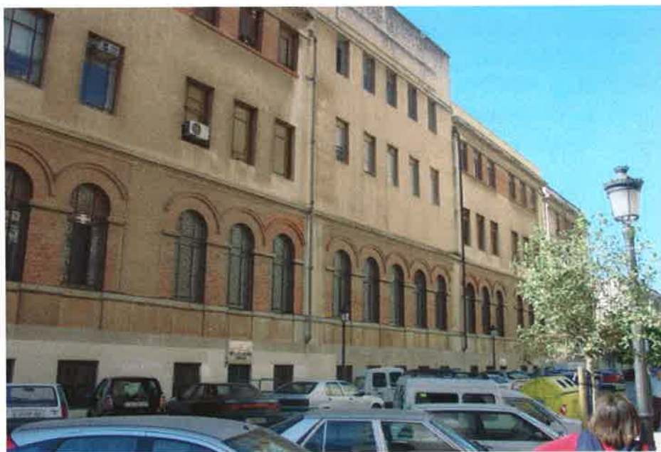
FACHADA POSTERIOR AVDA. MENÉNDEZ PELAYO
