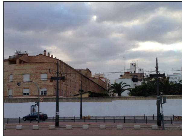
PUNTO DE OBSERVACION 8 · CALLE ALMAZORA
