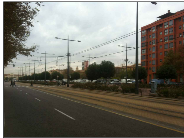
PUNTO DE OBSERVACION 6 · CALLE ALMAZORA
