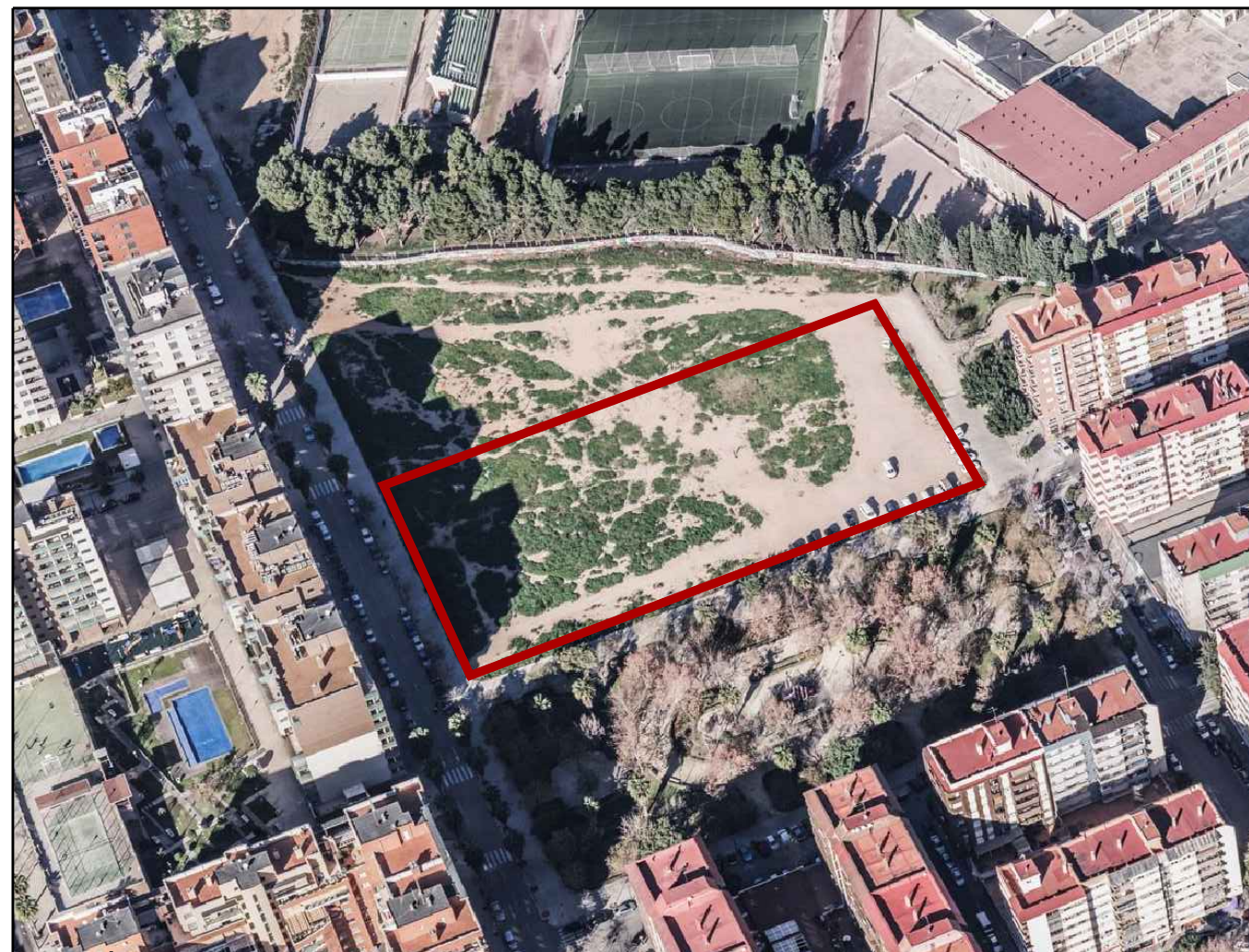
VISTA AEREA. SITUACION S/E
