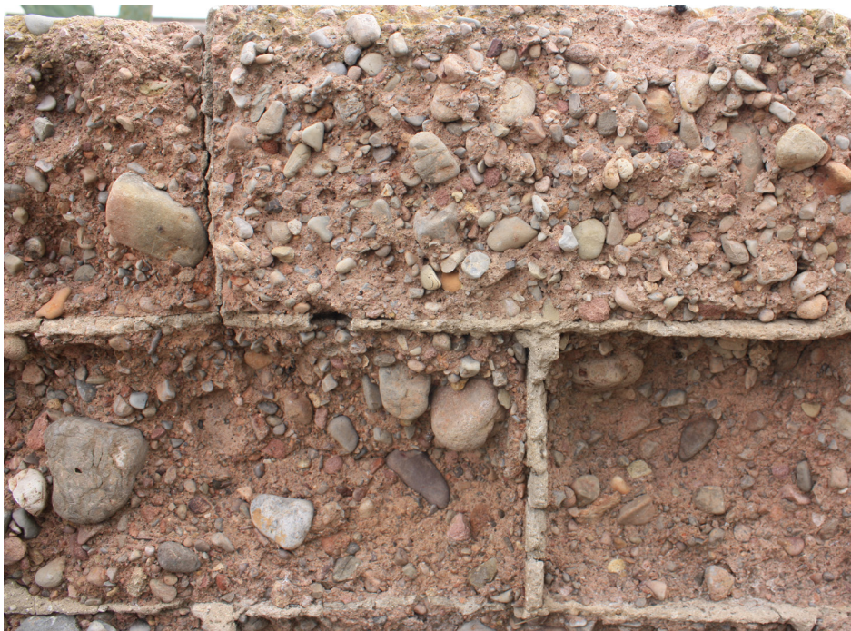
Figura 99. Muro realizado con bloques de hormigón. (Pastor, R. 2010)
