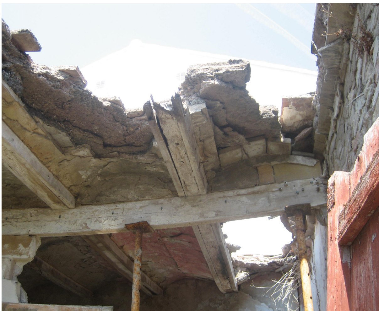
Figura 100. Sección forjado de revoltones. (Pastor, R. 2010)
