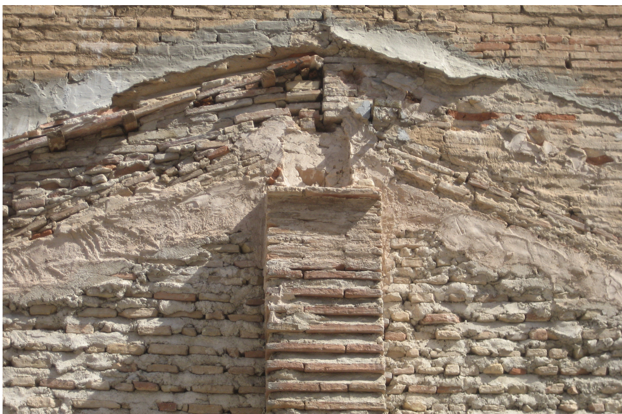
Figura 97. Detalle de medianera de ladrillo y pilastra. (Pastor, R. 2011)
