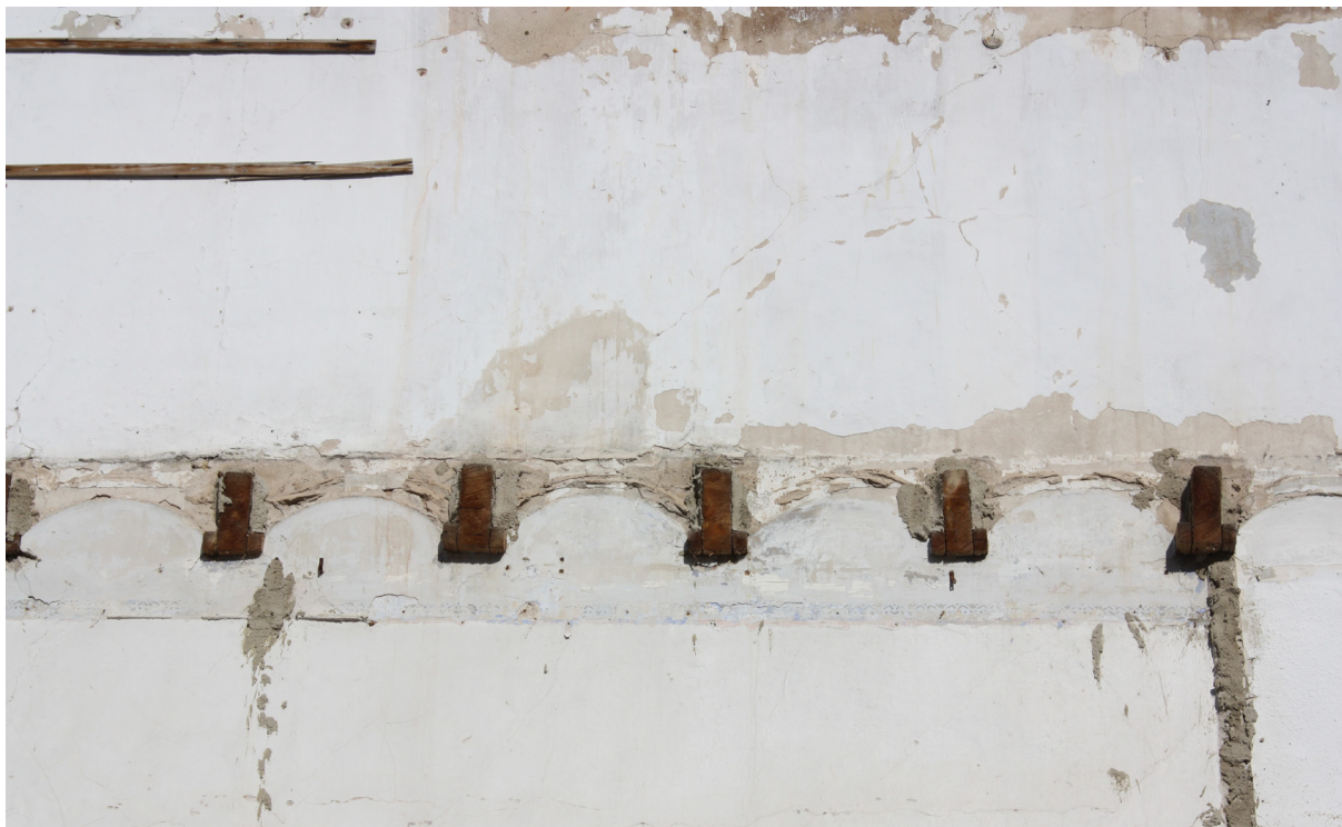
Figura 103. Apoyo de la bovedilla sobre dos listones laterales clavados a la viga. Derribo de edificio en calle Escalante. (Pastor, R. 2010)
