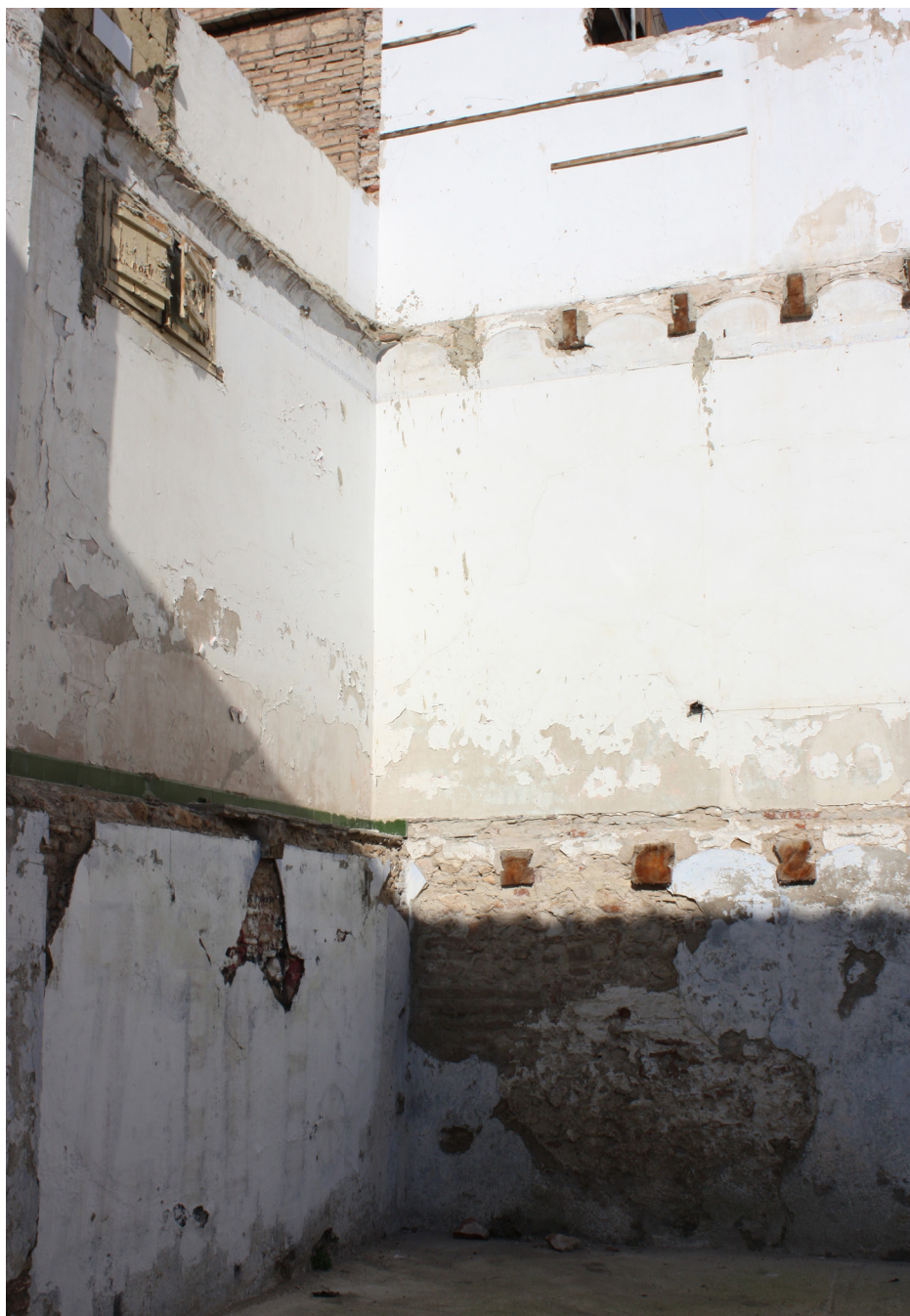
Figura 101. Vista de dos tipos de apoyo de bovedilla sobre vigueta de madera en derribo de edificio. (Pastor, R. 2010)
