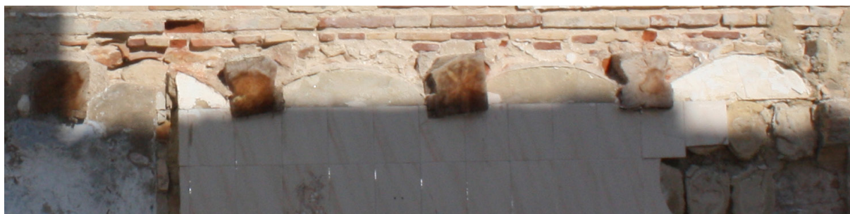
Figura 102. Detalle de vigueta en la que se han practicado unas muescas para el apoyo de la bovedilla. (Pastor, R. 2010)
