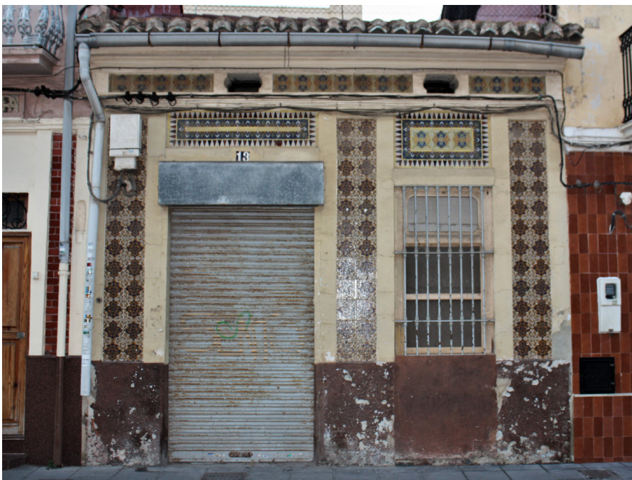
Figura 117. Vivienda en calle Espadán donde se observan los huecos en fachada que ventilan la cámara. (Pastor, R. 2011)
