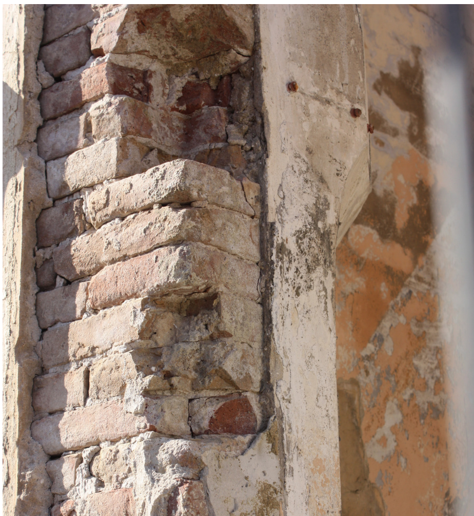
Figura 96. Detalle muro de fachada principal. (Pastor, R. 2011)
