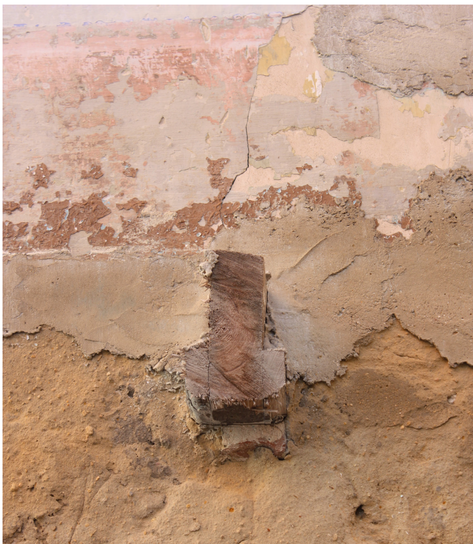
Figura 103. Apoyo de la bovedilla sobre dos listones laterales clavados a la viga. Derribo de edificio en calle Escalante. (Pastor, R. 2010)
