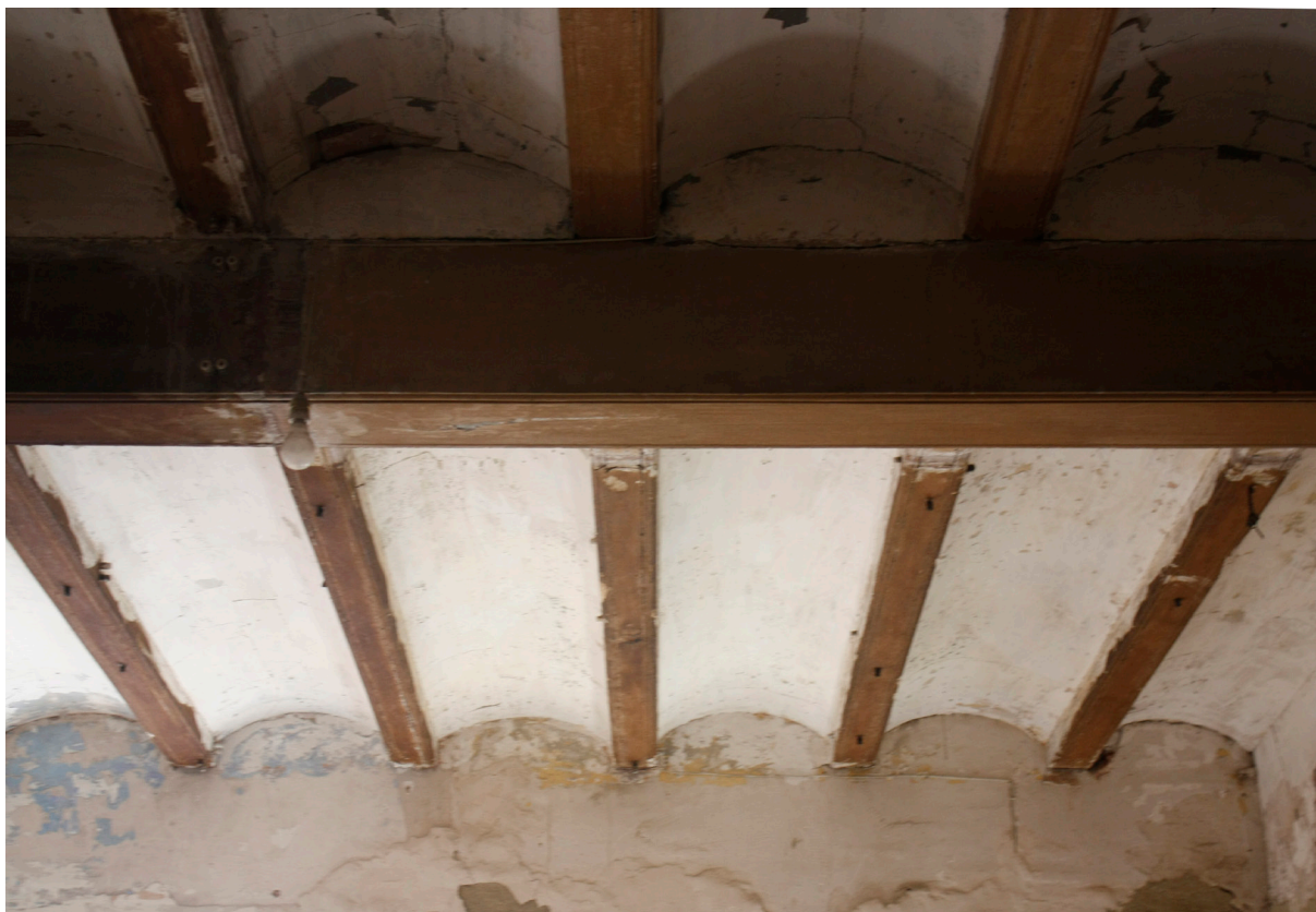
Figura 107. Interior forjado planta baja vivienda. Calle Rosario. (Pastor, R. 2016)
