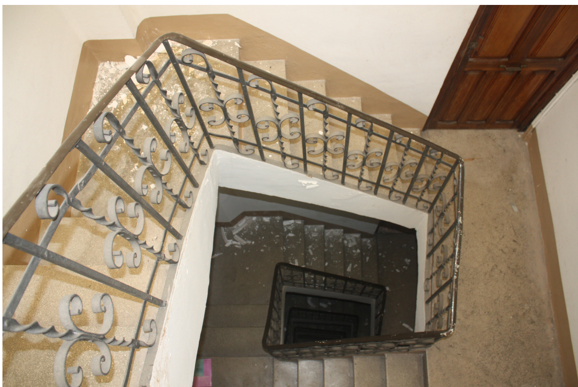
Figura 224. Interior escalera bóveda tabicada 4 tramos. Calle Escalante. (Pastor, R. 2015)
