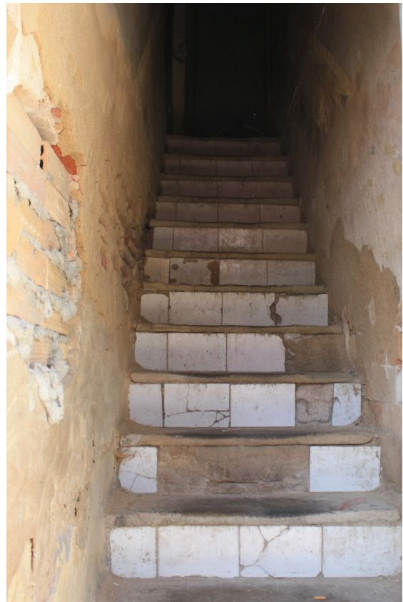
Figura 231. Contrahuellas revestidas material cerámico en calle José Benlliure 163 (Pastor, R. 2011)
