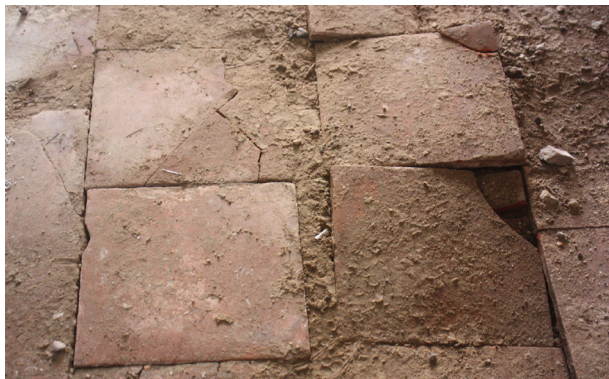
Figura 234. Pavimento pieza de barro calle Padre Luis Navarro. (Pastor, R. 2016)
