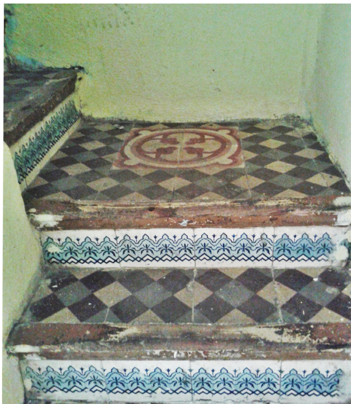
Figura 230. Contrahuellas revestidas material cerámico en calle Progreso (Pastor, R. 2017)
