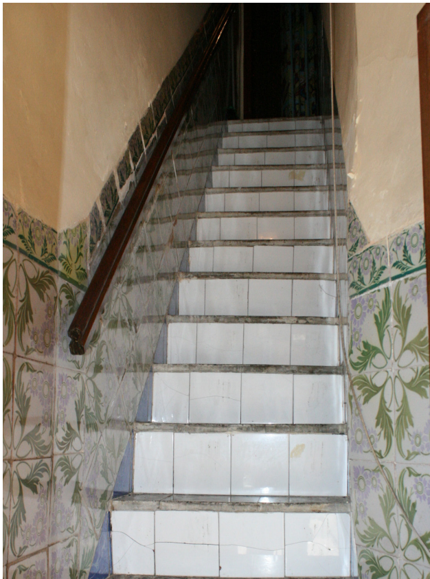
Figura 230. Contrahuellas revestidas material cerámico en calle Progreso (Pastor, R. 2017)
