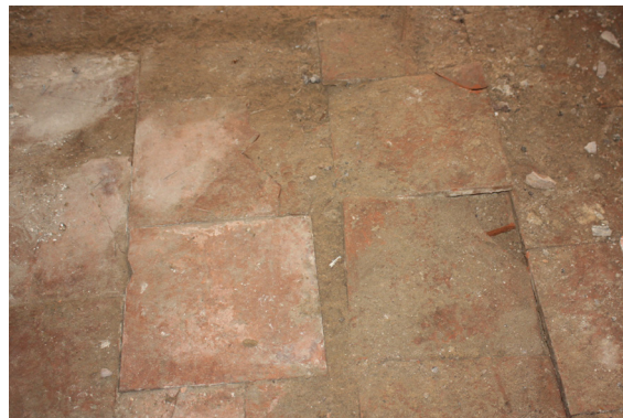
Figura 235. Pavimento hidráulico calle Padre Luis Navarro. (Pastor, R. 2016)
