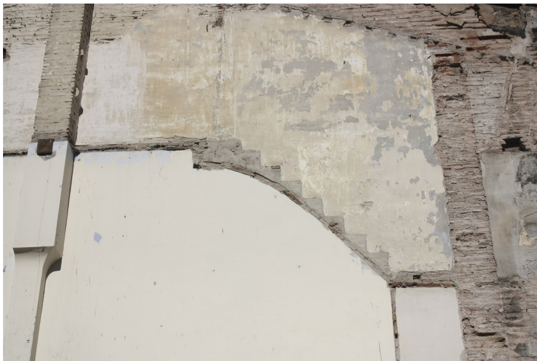
Figura 222. Huella de escalera realizada con bóveda tabicada. (Pastor, R. 2016)
