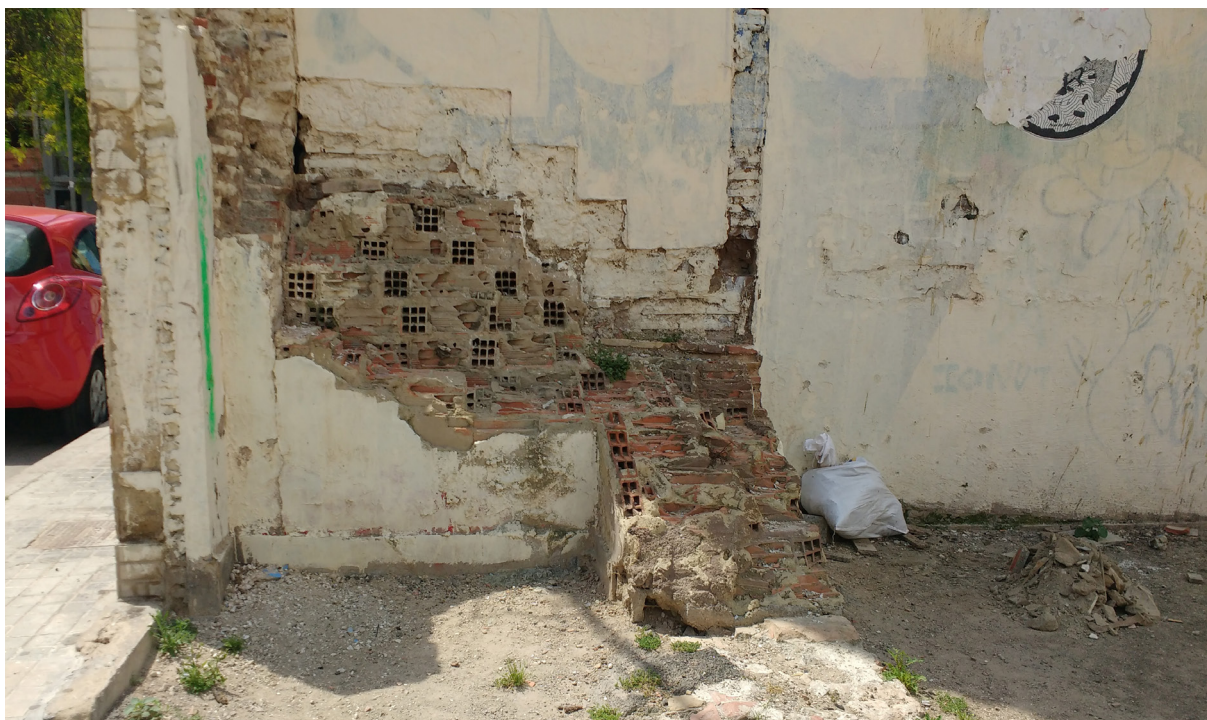
Figura 223. Arranque de escalera. Calle Escalante (Pastor, R. 2017)
