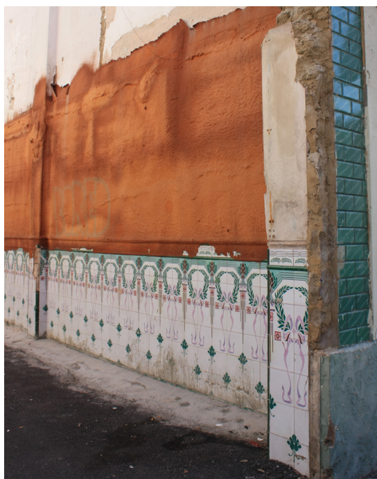
Figura 226. Derribo vivienda en calle Progreso. (Pastor, R. 2022)
