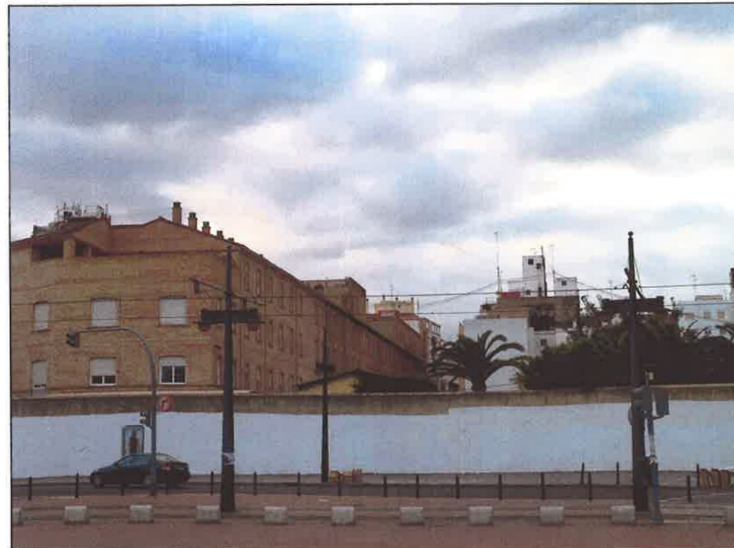
PUNTO DE OBSERVACION 8 · CALLE ALMAZORA · IMAGEN PREVIA
