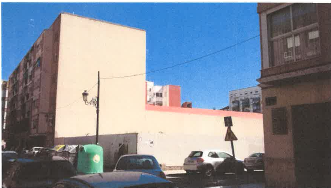
Medianera vista existente en la edificación recayente a la calle Muñiz y H. de Alba
