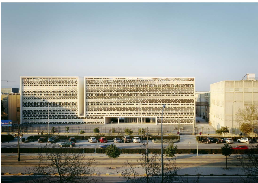
ETS de Ingenieros de Telecomunicaciones, Departamento de Idiomas y Centro de Lenguas.
