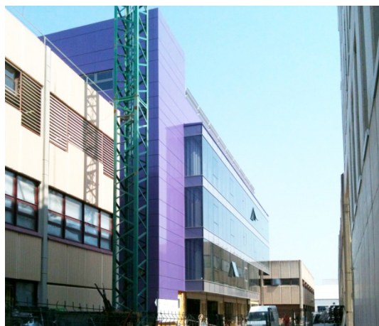
Ampliación de la ETSI de Caminos
