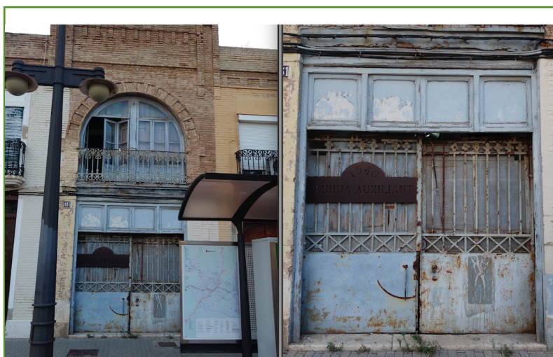
Detalles de remates, vanos y rejerías (2018).
