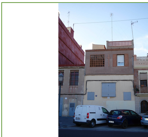
Arriba, detalles de la fachada. Sobre estas líneas, parte trasera del edificio (2018).
