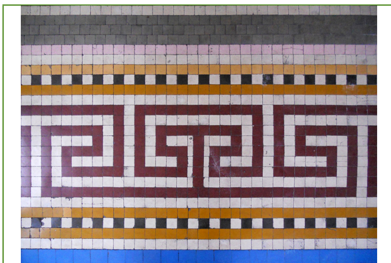
Ejemplos de elementos decorativos de techo (artesonado), paredes (azulejos) y suelo (mosaico) en el interior del colegio (Fuente: Vicente Gallart).
