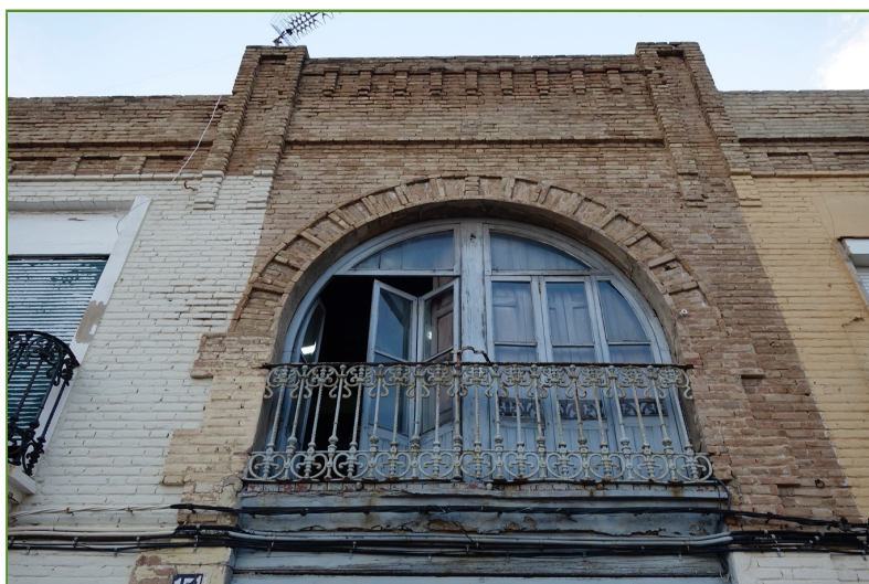
Arriba, fachada norte. En el centro, fachada longitudinal este. Abajo, detalle de ventanal (2018).
