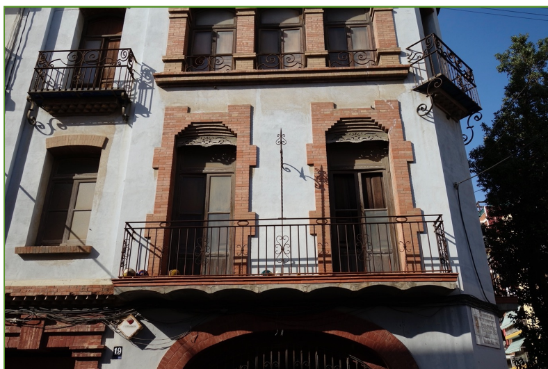
Esquina-chafalán y cuerpos laterales del edificio (2018).
