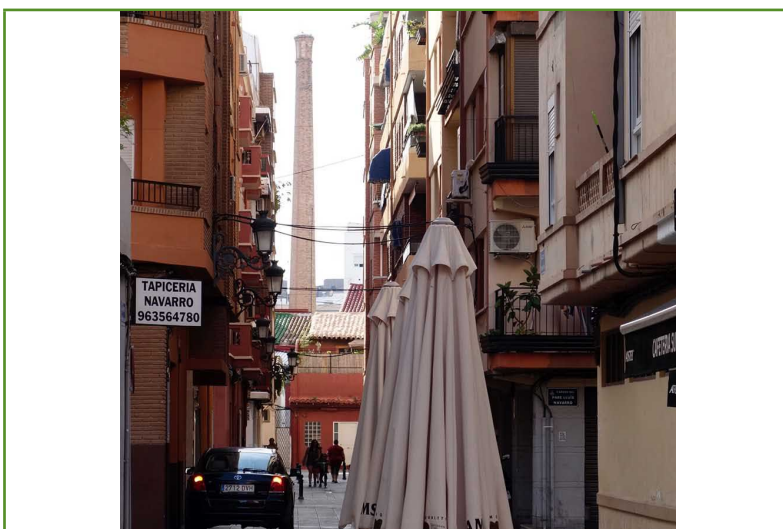
Distintas vistas de la chimenea desde los alrededores de la parcela (2018).
