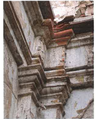
Detalle de la fachada interior del claustro
