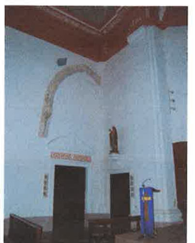
Vista interior del brazo izquierdo del transepto
