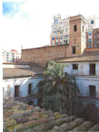
Vista del claustro desde la cubierta primera
