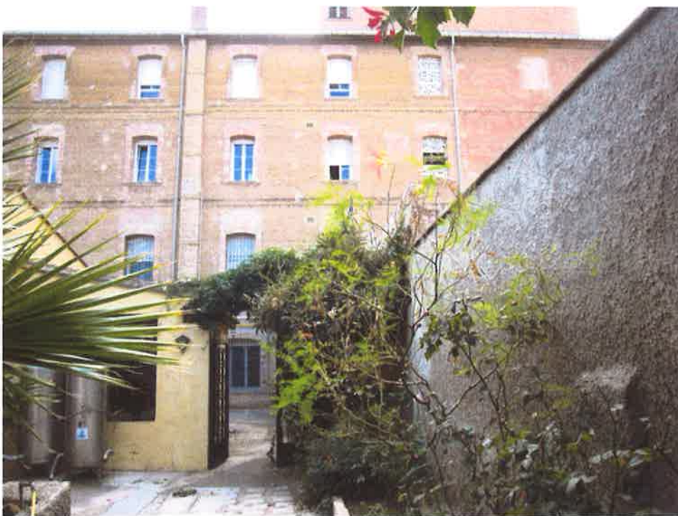
FOTO 6J · AREA DEL JARDIN NORTE · VISTA EDIFICIO RESIDENCIA Y MURO PERIMETRAL
