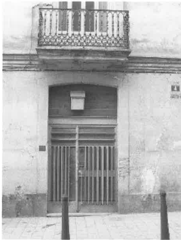
3. Acceso impropio a eliminar
