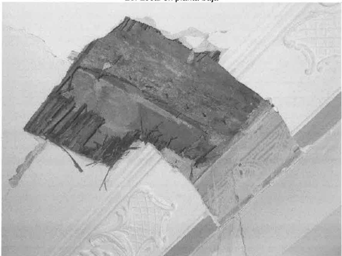
21. Detalle de construcción de forjados y techos. Nótese que las viguetas no están labradas para quedar vistas, sino que se colocan en basto y se clava a ellas el cañizo que sirve de base a la escayola
