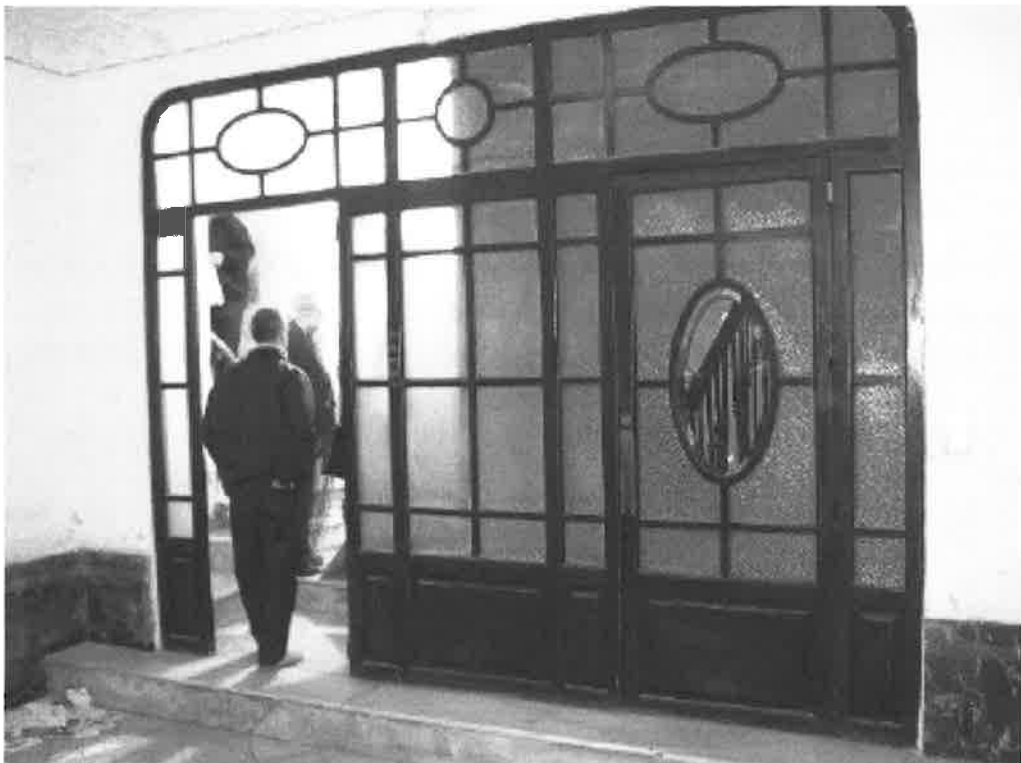
8. Zaguán. Mampara de madera y vidrio de acceso a escaleras
