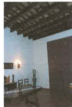
Vista sala interior con forjado de viguetas de madera
