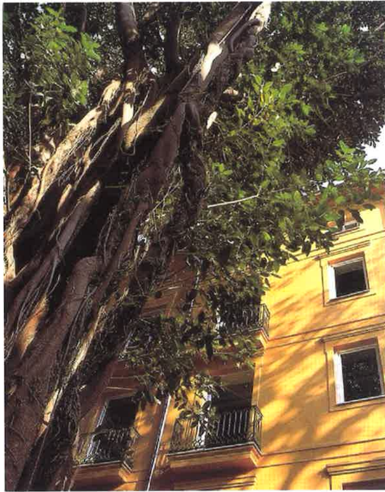
Aspecto del edificio desde el jardín del Palau de les Corts
