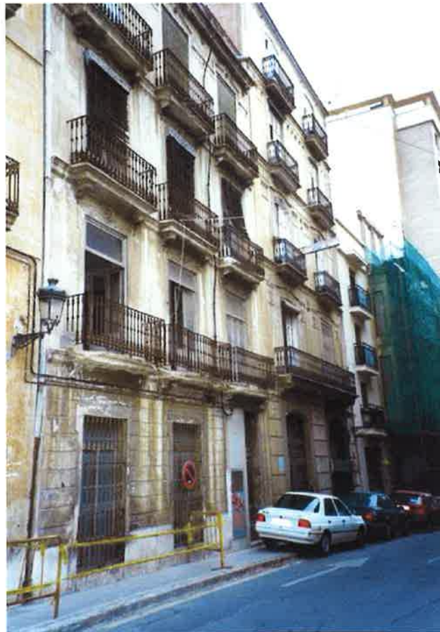
Imagen del deterioro del edificio
