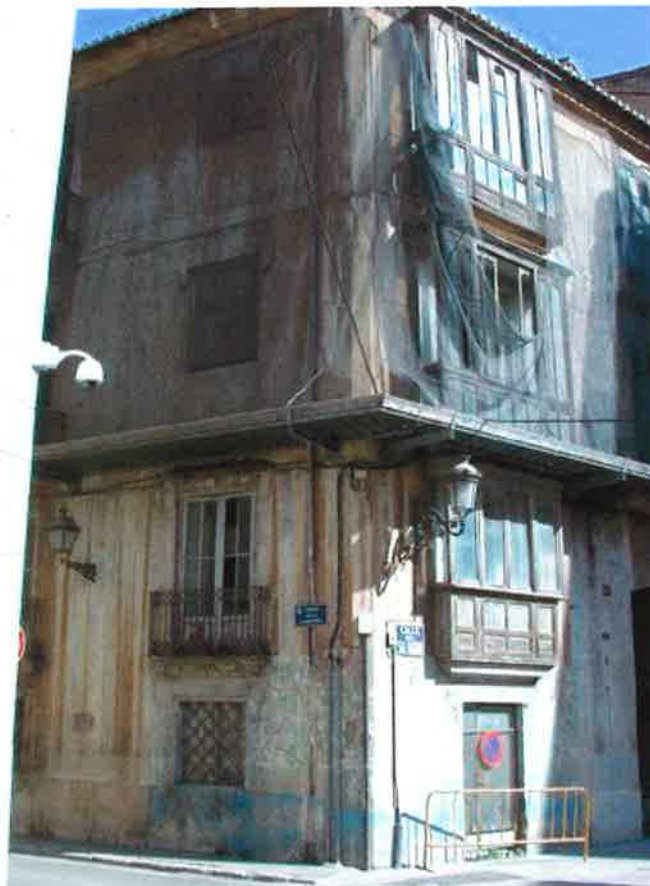
Estado actual con marquesina y lonas de protección
