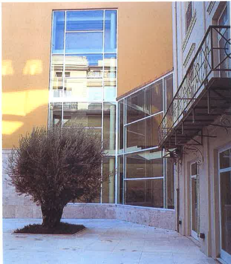
Frente del edificio al jardín de Conde de Trenor 3
