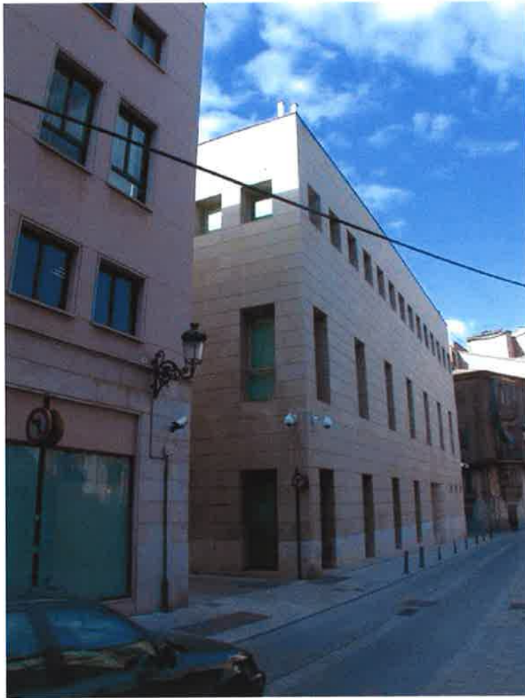
Presencia del edificio en la calle Salvador
