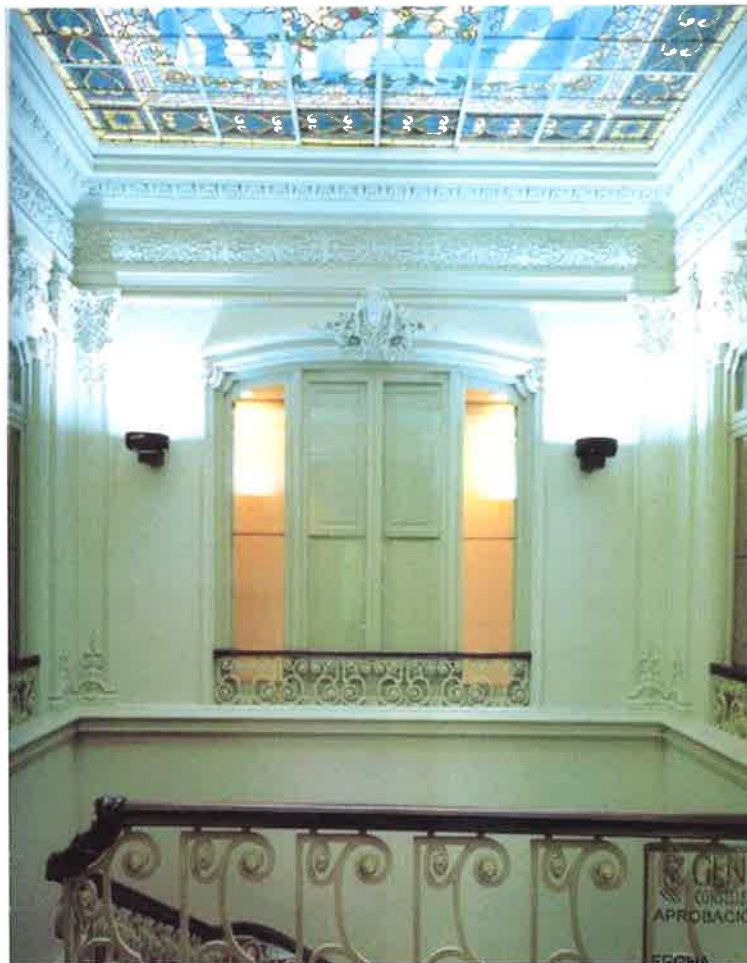
Claraboya situada sobre la escalera noble
