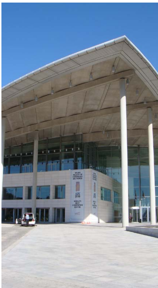
Fotografía nº 1.- Vista acceso principal Palacio de Congresos
