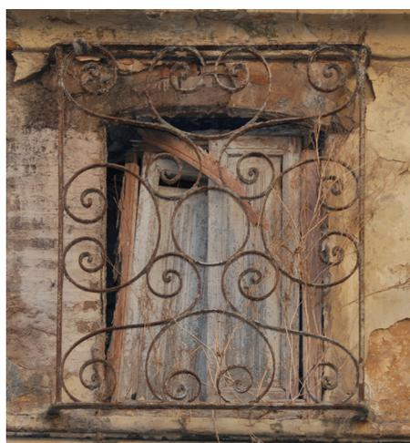
Figura 206.2. Reja ventilación cubierta calle Barraca 271 (1900). (Pastor, R. 2011)
