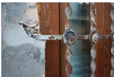
Figura 204.2. Detalle de anclaje acodillado a la fábrica. Calle Rosario (1925). (Pastor, R. 2022)
