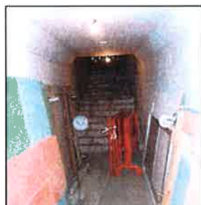
Escaleras de acceso
