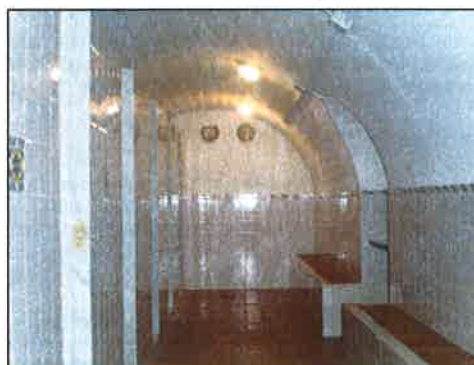
Vista actual del refugio reaprovechado como vestuario
