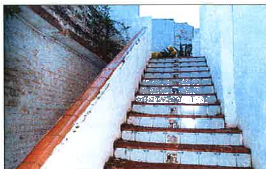
Escalera de acceso a la terraza
