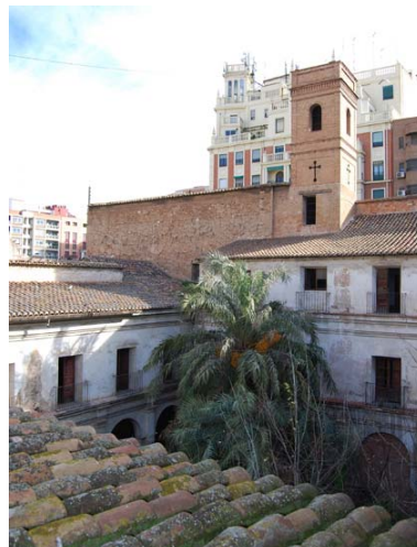
Vista del claustro desde la cubierta
