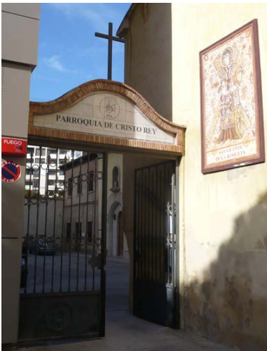
Vista del acceso actual
