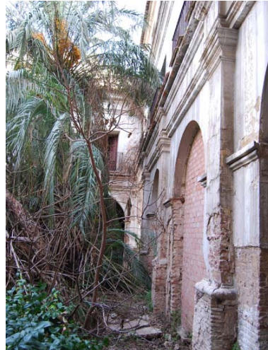
Vista el patio del claustro de los andadores perimetrales
