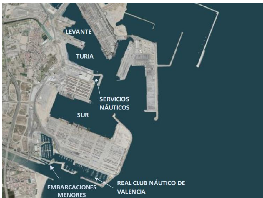
Figura 7: Dársenas de la Zona Sur del Puerto de Valencia
