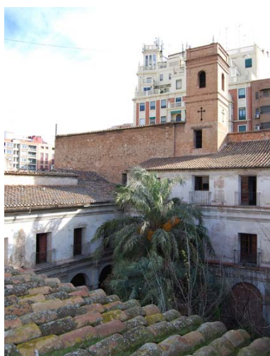
Vista del claustro desde la cubierta
