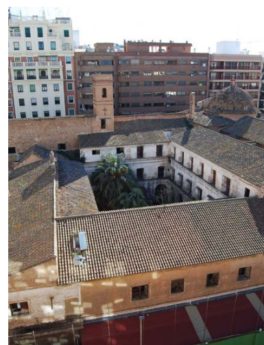
Vista del claustro desde edificaciones adyacentes
