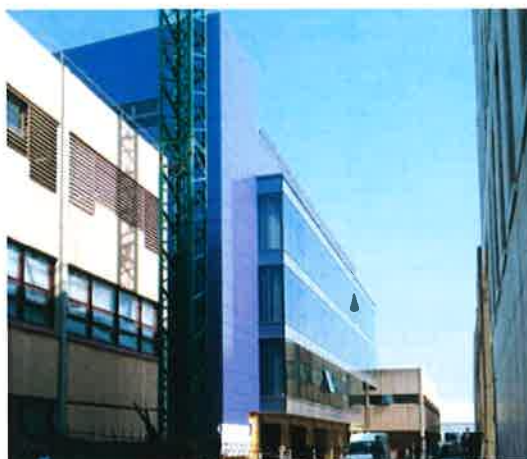
Ampliación de la ETSI de Caminos
