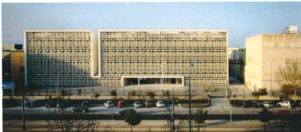
ETS de Ingenieros de Telecomunicaciones, Departamento de Idiomas y Centro de Lenguas.
