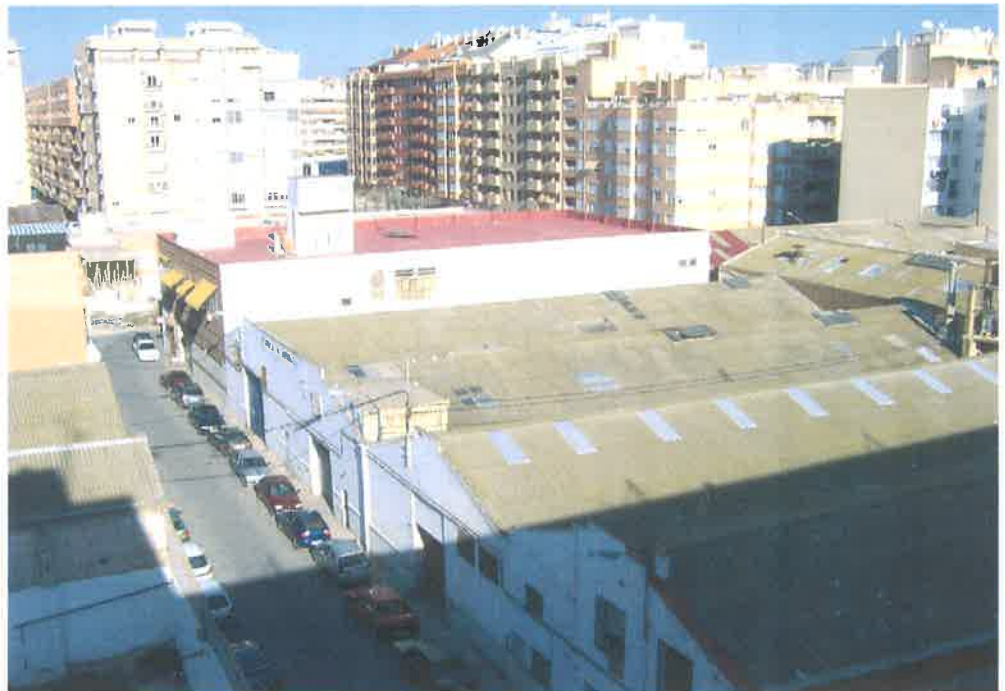
CALLE BENIGANIM A LA DERECHA, NAVES A SUSTITUIR
