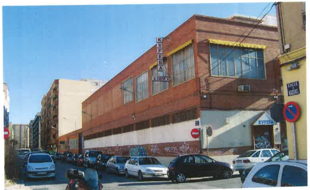
CALLE MADERAS A LA DERECHA, ENCUENTRO CON CALLE BENIGANIM ESQUINA DE NAVES A SUSTITUIR
