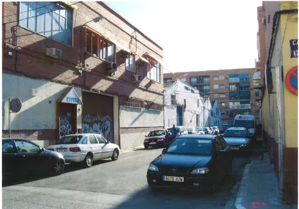
CALLE BENIGANIM A LA IZQUIERDA, NAVES A SUSTITUIR
