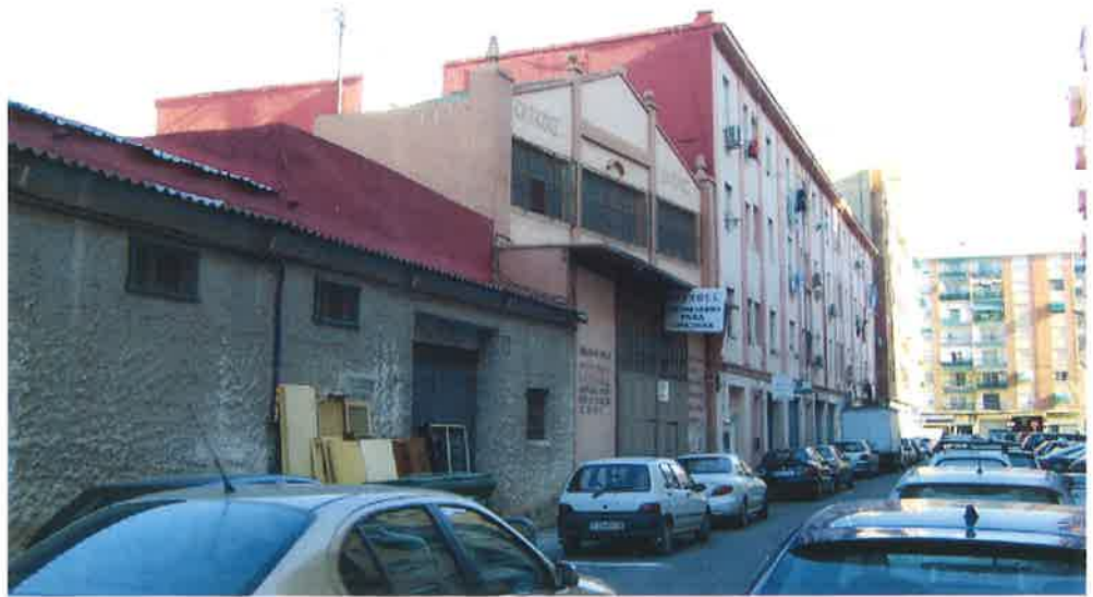
CALLE ALCALDE CANO COLOMA EN PRIMER PLANO, NAVES A SUSTITUIR DETRÁS, EDIFICIO A RESPETAR
