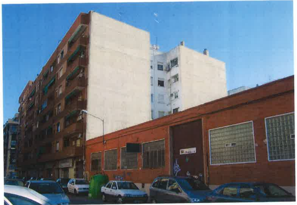
CALLE MADERAS. EDIFICIO A RESPETAR, Y NAVE A SUSTITUIR
