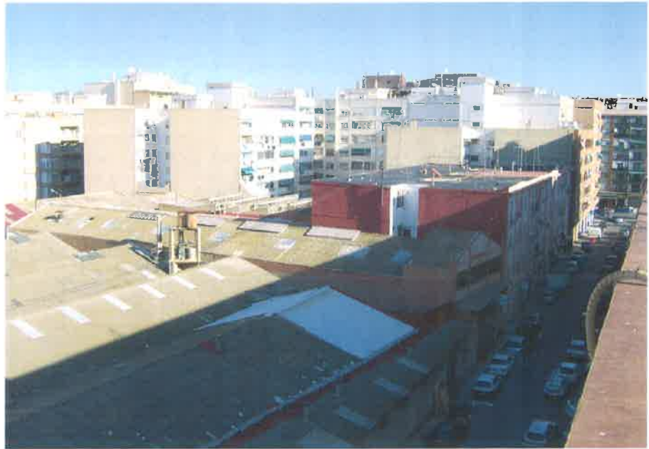
CALLE ALCALDE CANO COLOMA EN PRIMER PLANO, NAVES A SUSTITUIR DETRÁS, MEDIANERAS DE EDIFICIOS QUE SE RESPETAN
