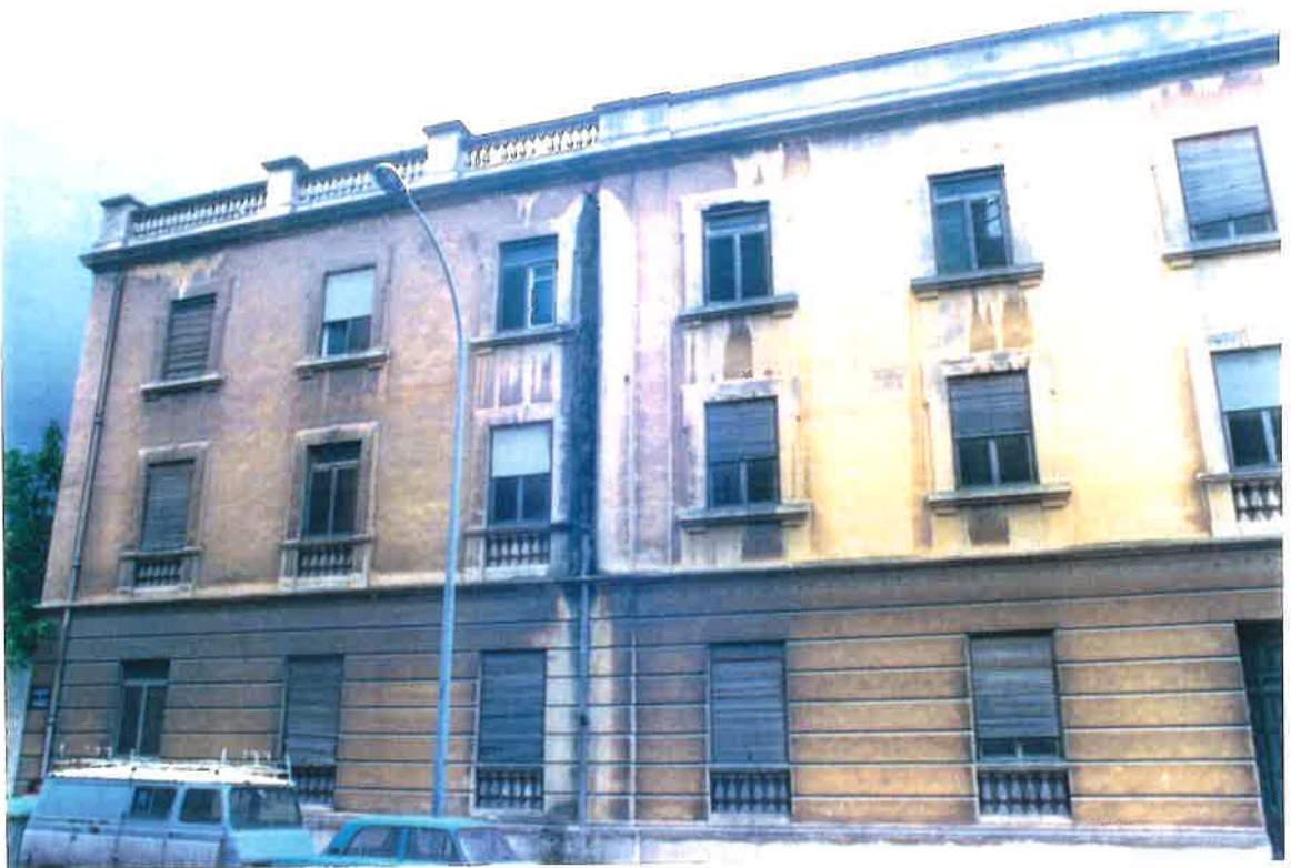
EDIFICIO (6). FACHADA CALLE ZAPADORES.
