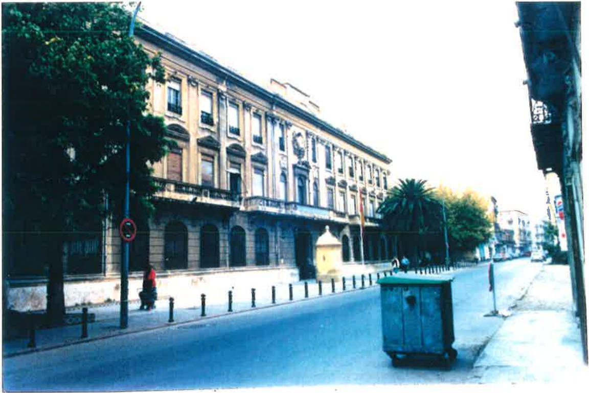
EDIFICIO (1). FACHADA CALLE ZAPADORES.
