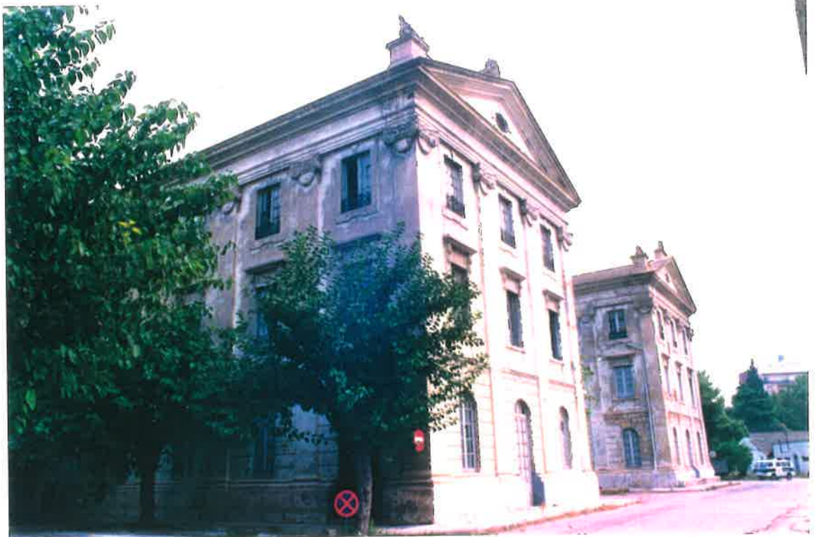
EDIFICIO (2). FACHADA LATERAL.
