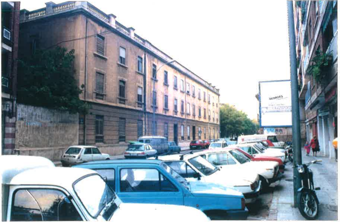
EDIFICIO (6). FACHADA CALLE ZAPADORES.
