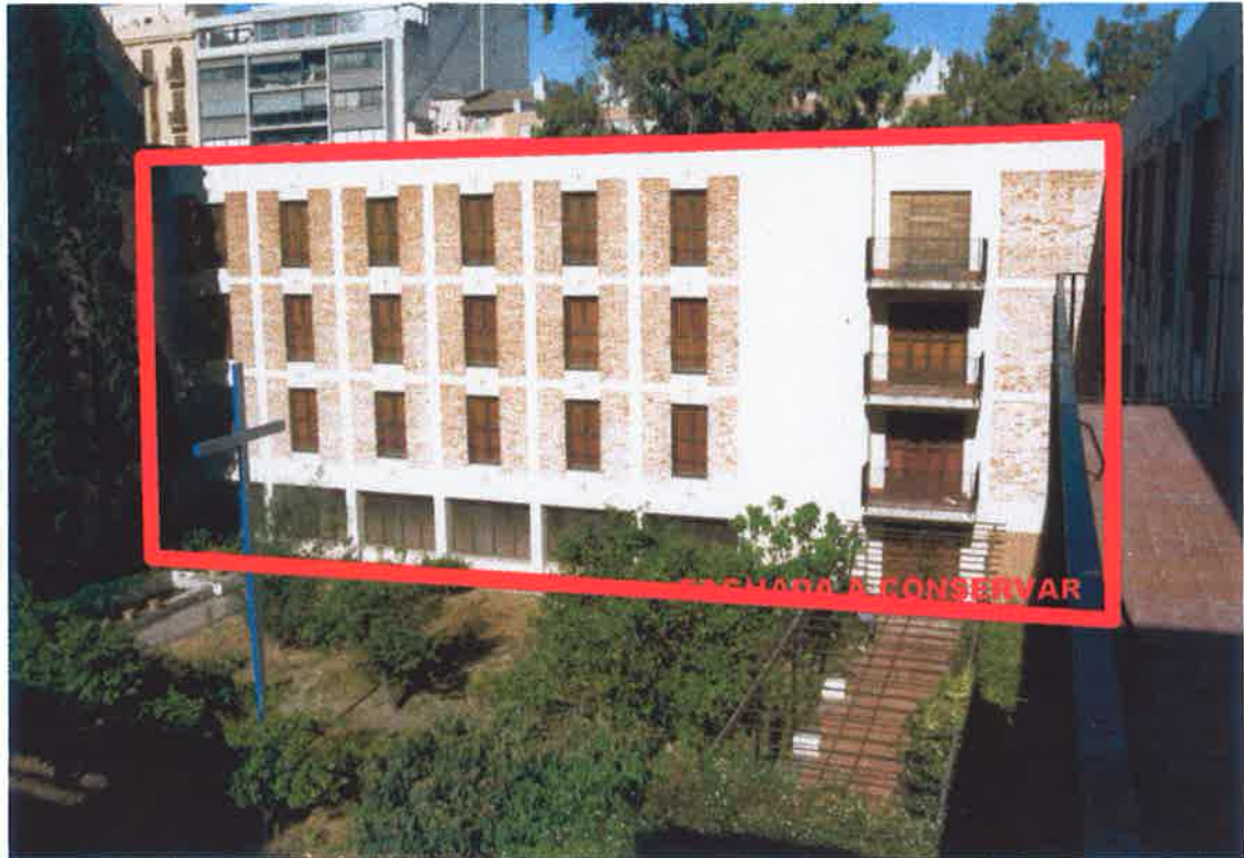
Vista de la fachada este al patio interior
