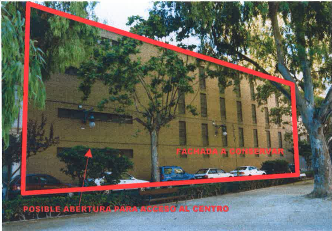
Vista de la fachada a c/ Guillén de Castro
