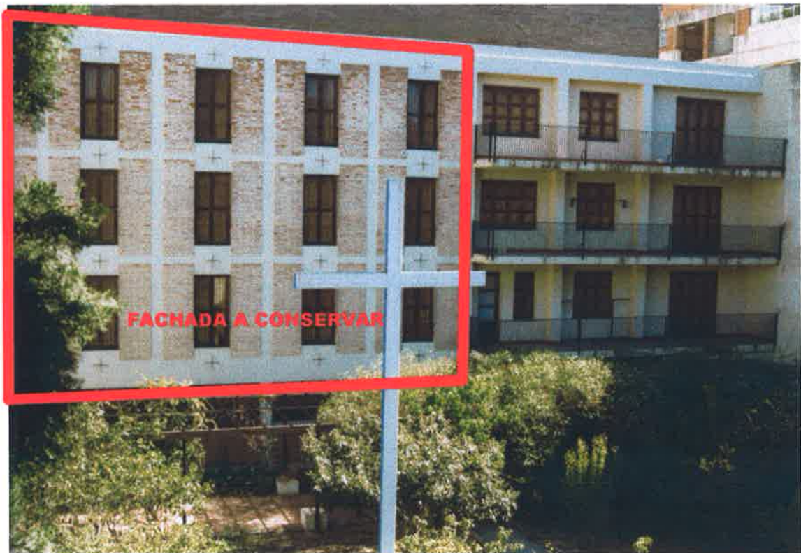
Vista de la fachada norte al patio interior
