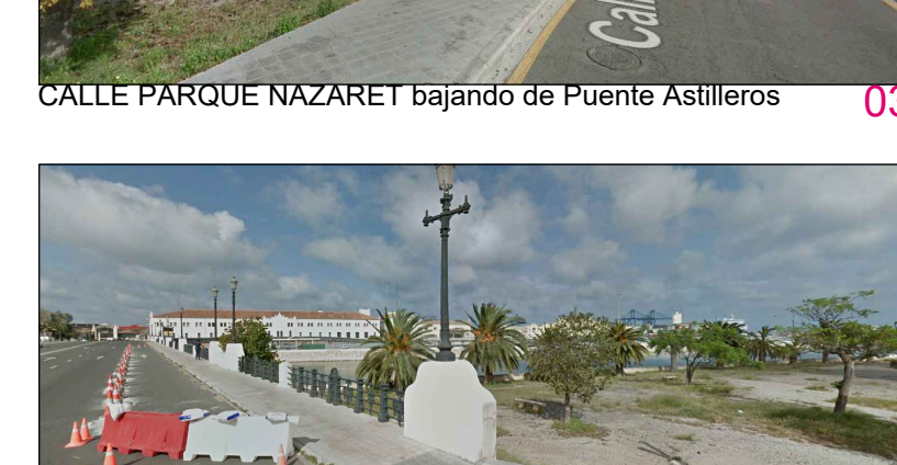
PUENTE DE ASTILLEROS 2 02
