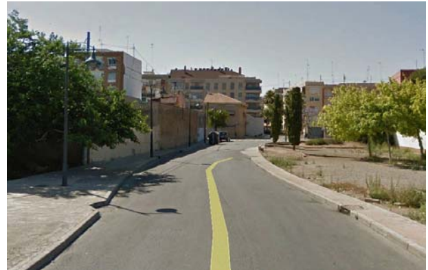
Castell de Pop, tramo sin bandas de aparcamiento
