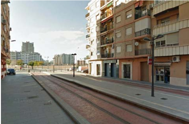
Plataforma de la futura Línea 10 de en calle Fontilles
