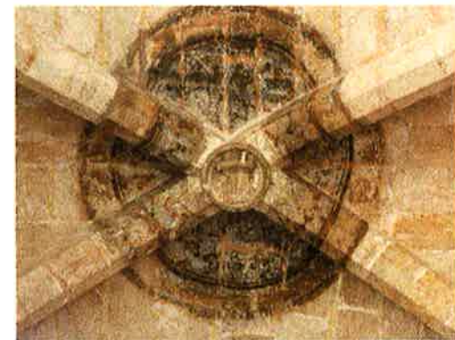
Detalle de policromía en la clave de la bóveda de crucería de planta primera. [Equipo Redactor]
