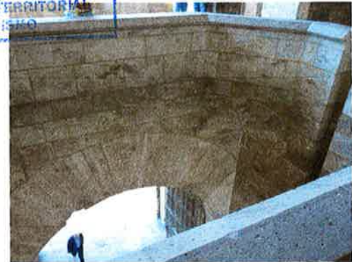
Vista desde planta primera del paso inferior de la torre. [Equipo Redactor]
