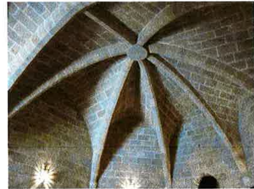
Bóveda de crucería heptapartita de planta baja. [Equipo Redactor]
