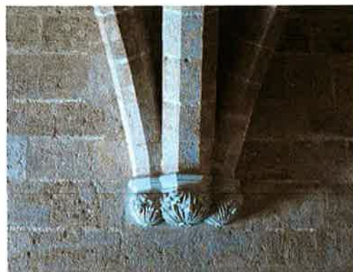
Detalle de la ménsula, procedente de las restauraciones desarrolladas por J. Rieta, que sirve de arranque a los nervios de las bóvedas de planta baja. [Equipo Redactor]
