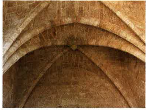
Bóveda de crucería de planta segunda. [Equipo Redactor]
