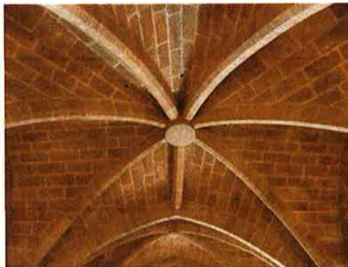
Vista cenital de la bóveda de crucería heptapartita de planta baja. [Equipo Redactor]
