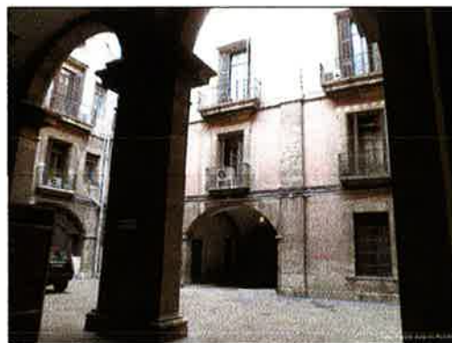
Vista interior. (Fuente: Marcos Buigues Metola)
