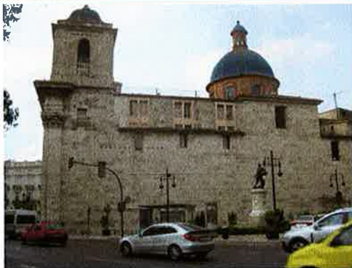
Ise observa en la fachada lateral las dos plantas levantadas por la iglesia sobre las capillas laterales y los mechinales de la unión de la muralla musulmana.
