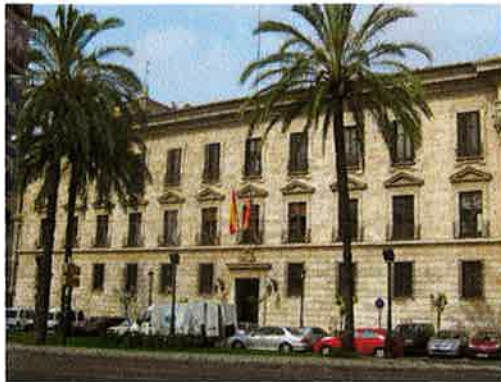
Monasterio. Fachada principal. [Equipo Redactor]
