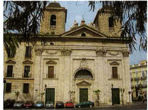
Iglesia. Fachada principal. [Equipo Redactor]
