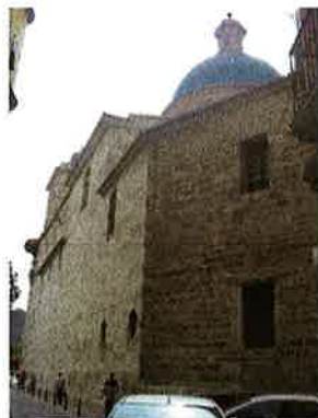
Iglesia: Fachada vista desde la calle Trinitarios. [Equipo Redactor]
