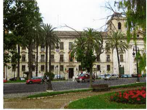
Vista de la fachada principal en la actualidad. [Equipo Redactor]
