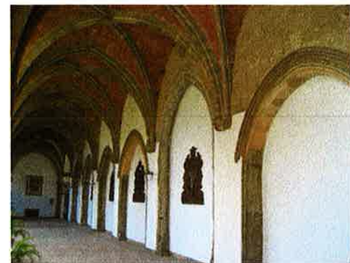
Vista de las bóvedas de la panda del Claustro Mayor [Equipo Redactor].
