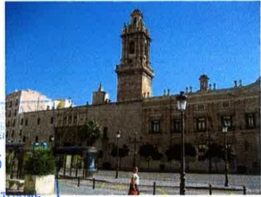
Fachada principal [Equipo Redactor].
