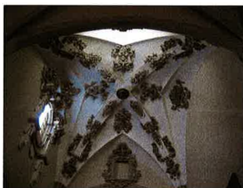
Bóveda barroca del tramo inicial de la primitiva iglesia, pudiéndose observar en los arranques el gótico original [Equipo Redactor].
