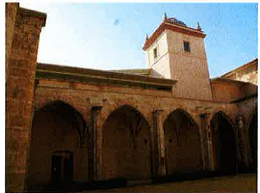
Vista del claustro gótico hacia el cuerpo de la escalera principal del convento, con cúpula de teja vidriada azul. [Equipo Redactor]
