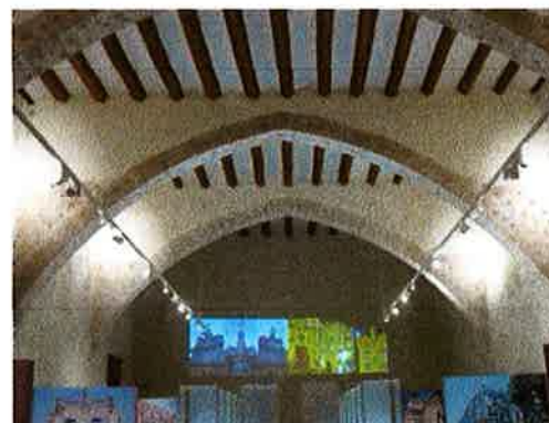
Vista del refectorio tras la última intervención. [Equipo Redactor]
