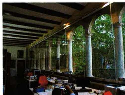
Vista de la panda sur de la planta primera del claustro renacentista tras su última intervención. [Equipo Redactor]
