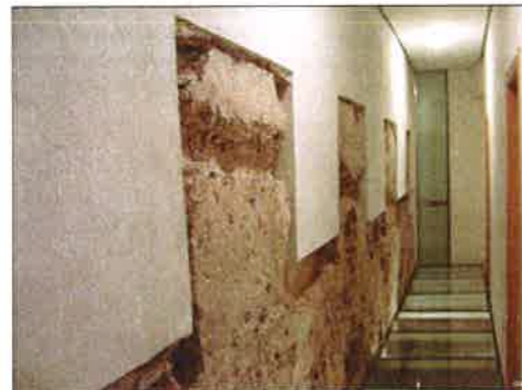
Almenas de la muralla en la C/ Blanquerías
