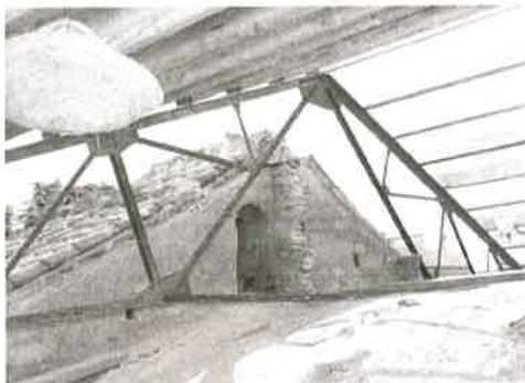
Fotografía histórica. Construcción de la sobrecubierta
