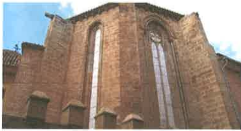
Vista del presbiterio desde el exterior
