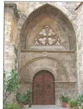
Vista de la portada en la fachada norte. (Fuente: www.jdiezarnal.com )
