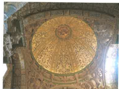
Vista interior bóveda de la Capilla Santa Bárbara
