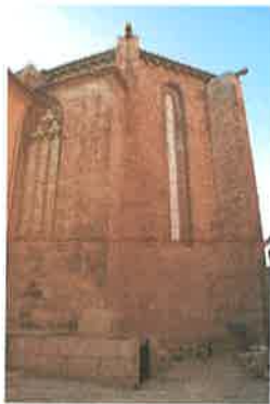
Vista del presbiterio desde el exterior
