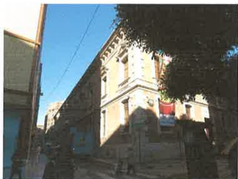
Vista de la fachada esquina la calle Salvá con calle Univeridad
