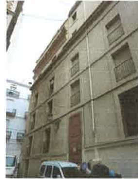
Vista fachada recayente a calle Virues
