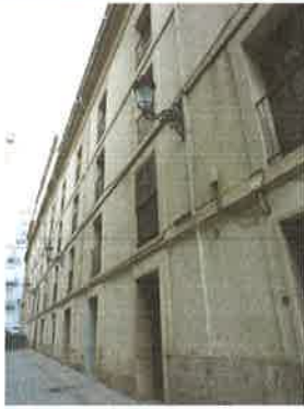
Vista fachada recayente a calle Virues
