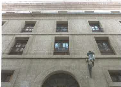
Detalle fachada recayente a calle Ballesteros
