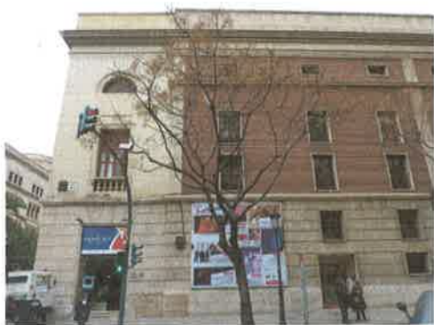
Vista detalle fachada lateral recayente a la calle Poeta
