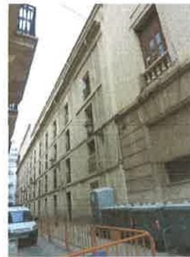
Vista fachada recayente a calle Virues
