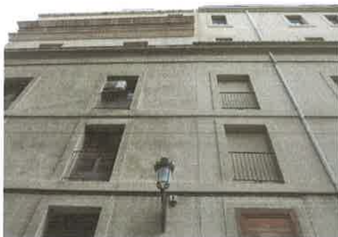
Detalle fachada recayente a calle Virues
