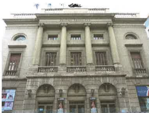
Vista fachada principal desde la calle Barcas
