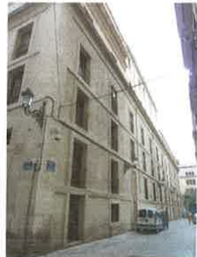
Vista fachada recayente a calle Virues
