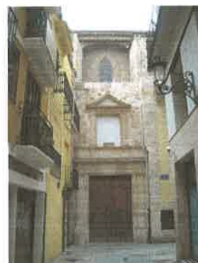
Vista de la fachada desde la calle Tapinería
