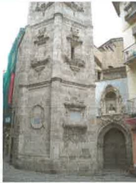
Vista de la base de la Torre-campanario desde la plaza de Sta.
