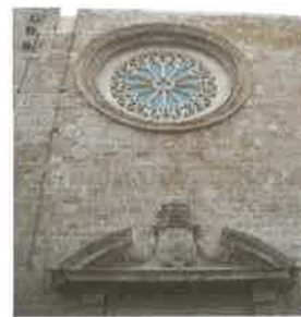
Detalle de la fachada principal: rosetón
