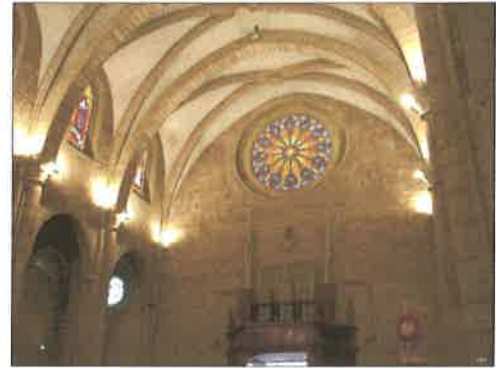
Vista interior bóvedas (Fuente: www.jdiezarnal.com )
