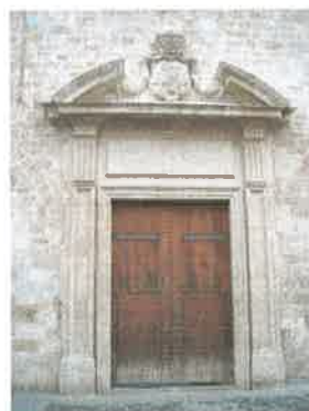
Detalle de la fachada principal: portada
