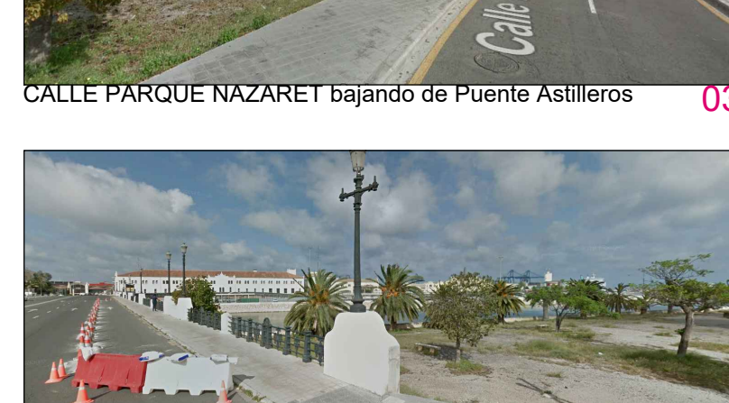
PUENTE DE ASTILLEROS 2 08
