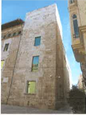
Torre en fachada vista desde Pza. San Lorenzo
