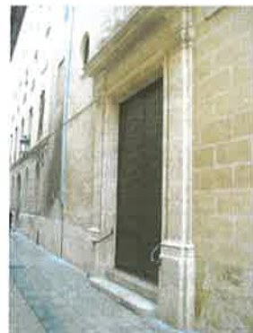
Vista de la portada recayente a la C/ Franciscanos.
