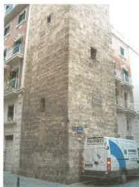
Vista de la parte inferior de la Torre, donde se observa la fábrica de sillería.
