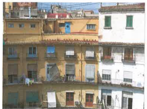
Imagen de las fachadas recayentes a la Plaza, 2007. (Fuente: web www.vtim.es )
