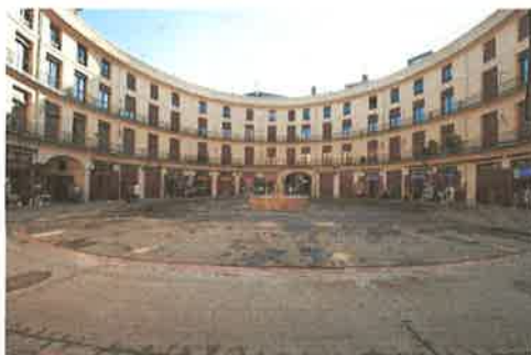
Imagen desde el interior de la Plaza, 2007. Tras la primera fase de rehabilitación, tras la eliminación de la cubierta de 1916 y antes de la construcción de la nueva
