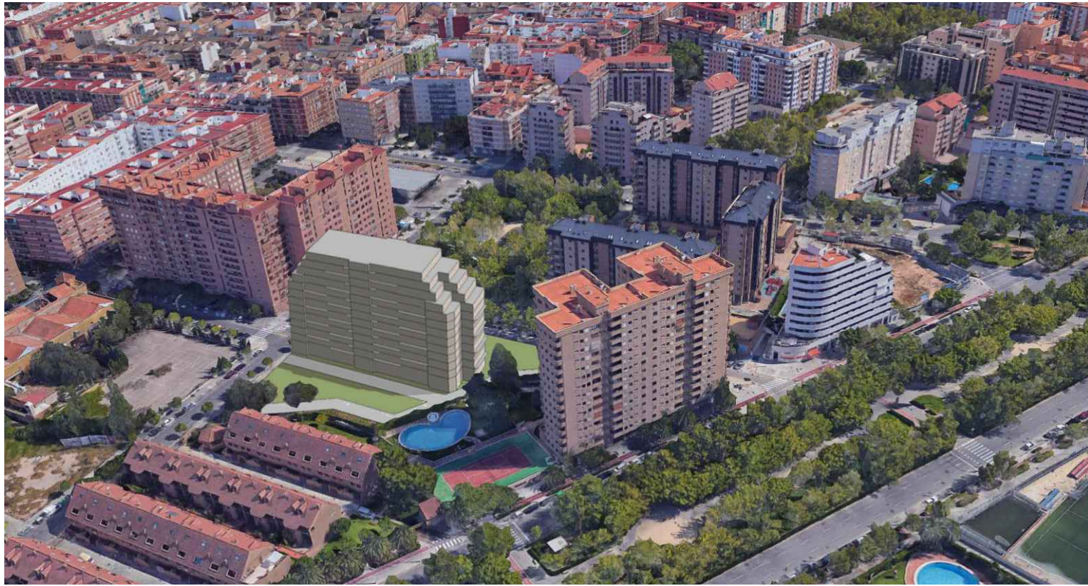
Vista aérea desde la esquina noroeste (no vinculante)
