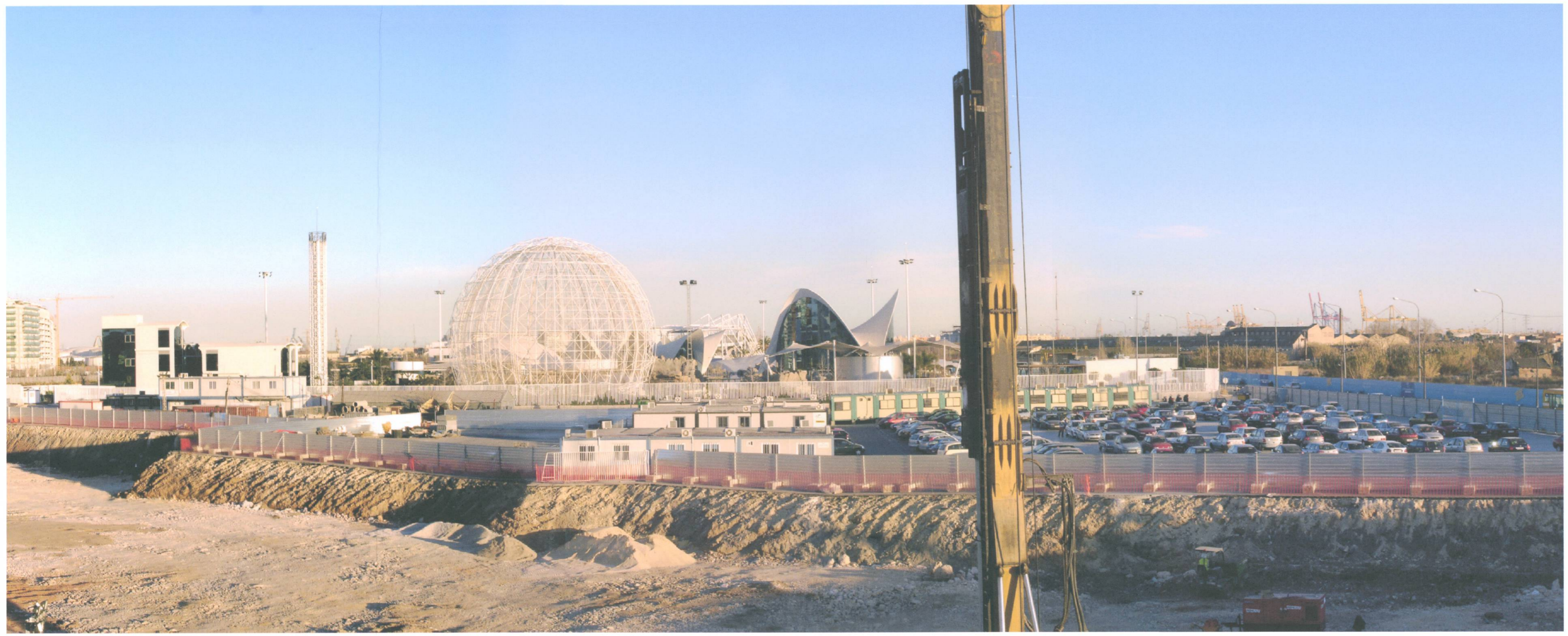
VISTA DE UNIDAD URBANA M1 DESDE EL FUTURO PUENTE DE SERRERIA
