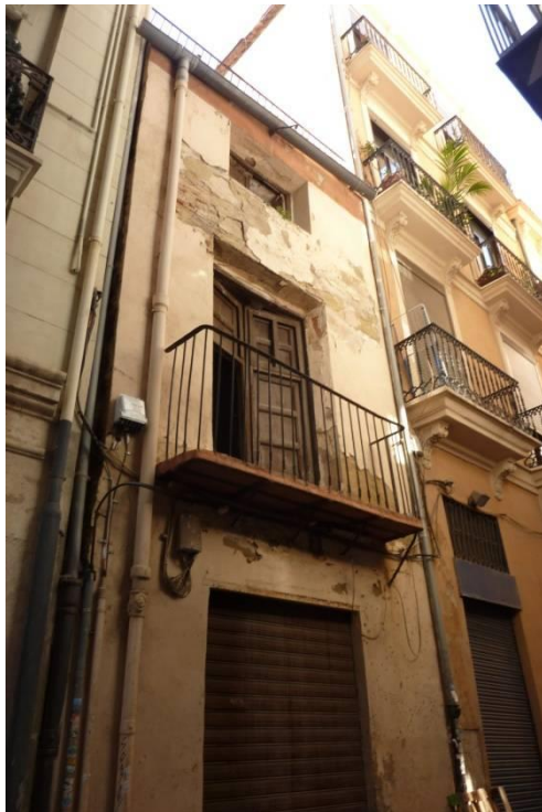
Casa obrado en calle Aluders 3
