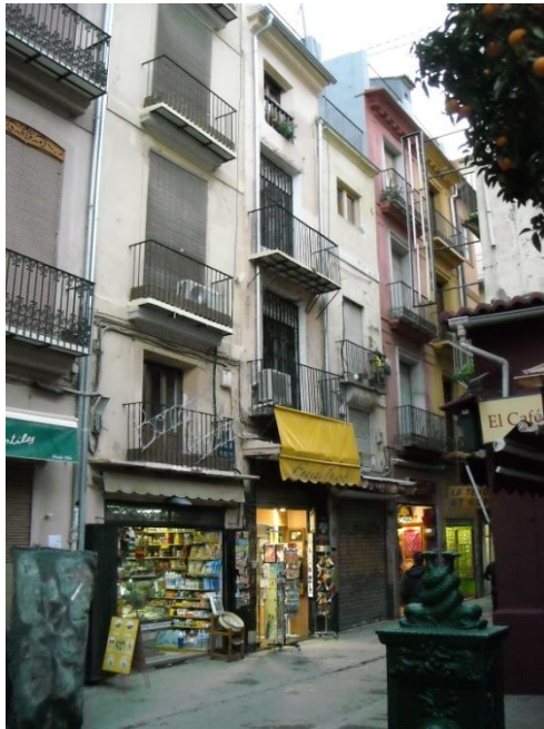
Casas obrador (edificios plurifamiliares) en calle Trench
