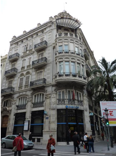
Banco del Río de la Plata de Luis Ferreres (actual Hotel Reina Victoria). Calle Barcas 4.
